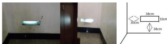
Gambar 4. Lubang Ventilasi Bawah Sumber: Data Peneliti
