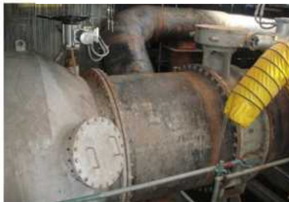
Dokumentasi PLTU 1 Jawa Barat Indramayu Gambar 2.23 Debris Filter A
