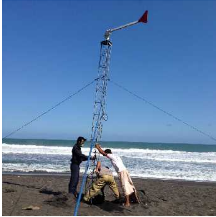
Gambar 3.35 Pemasangan menara turbin angin
