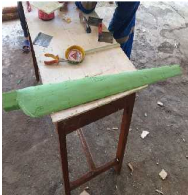
Gambar 3.13 Proses Pendempulan Pada Inti Cetakan
