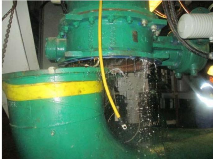
Gambar 2.21 Pelepasan sisi inlet CWHE
