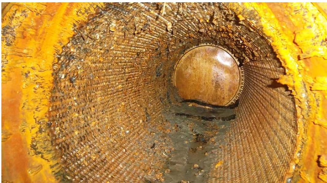
Gambar 2.20 Kotoran pada sisi masuk air laut
