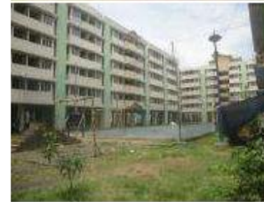
- Penghijauan di lantai dasar bangunan
