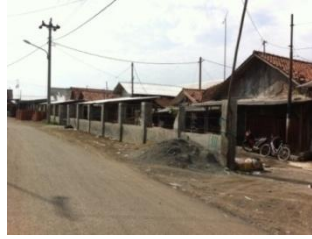
Gambar3.11 Tempat Pelelangan Ikan (TPI) di Muarareja
