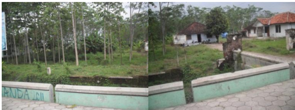
Gambar 5.2 Kondisi Tapak Terpilih Sumber: Dokumen Pribadi
