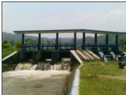
Pintu Air Bendung Kupang Krompeng
