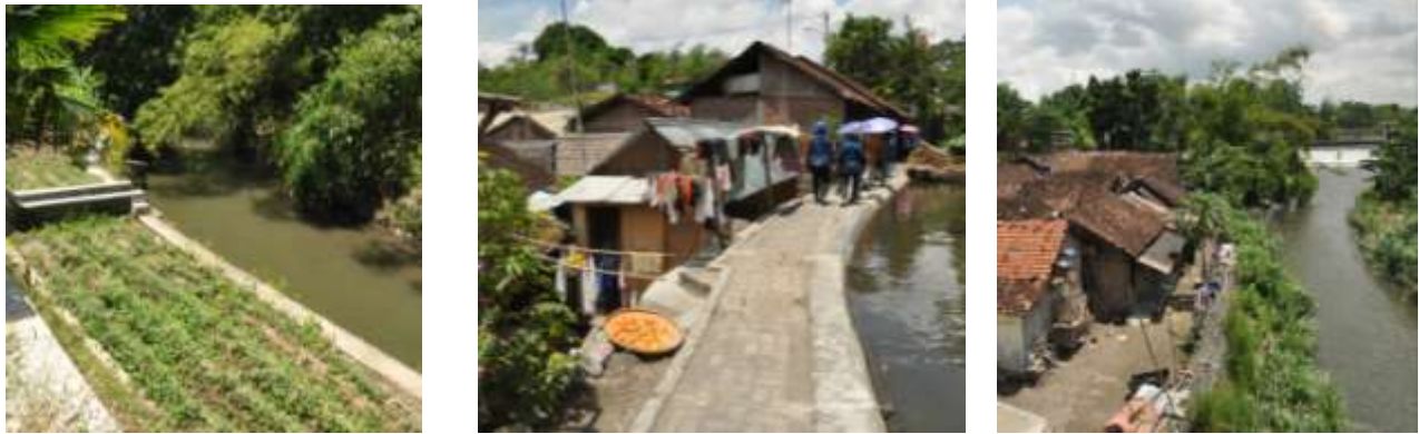
Gambar 5.7. Gambar Kondisi site yang akan ditata Sumber :Dokumen Pribadi, 2013
