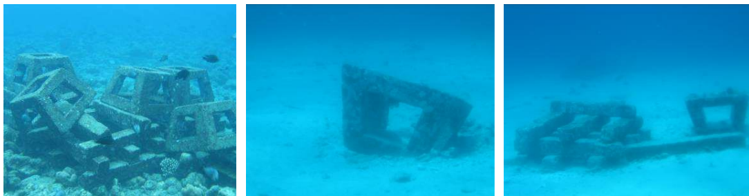
Gambar 1. Kerusakan terumbu buatan di perairan Sabang, Nanggro Aceh Darussalam
