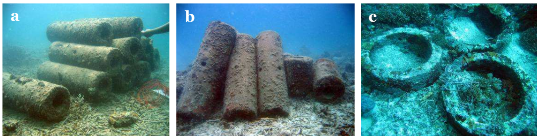
Gambar 3. Susunan terumbu buatan berbentuk pipa yang terlepas talinya di P. Sembilan Sinjai (a,b) dan terkuburnya terumbu buatan buis beton di P. Nusa Lembongan Kep. Nusa Penida, Bali (c)
