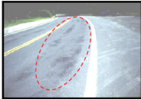
Gambar 2.4 Kerusakan Bleeding (I Nyoman Jagat Maya, 2011)
