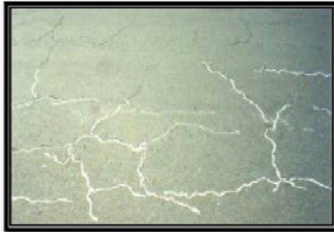
Gambar 2.10 Kerusakan : Retak blok(I Nyoman Jagat Maya, 2011)
