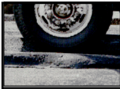
Gambar 2.17 Kerusakan : deformasi plastis(I Nyoman Jagat Maya, 2011)
