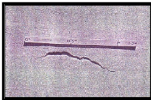
Gambar 2.8 Kerusakan : Retak selip(I Nyoman Jagat Maya, 2011)
