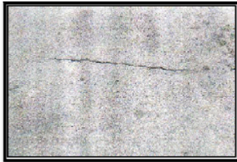
Gambar 2.12 Kerusakan : Retak melintang(I Nyoman Jagat Maya, 2011)
