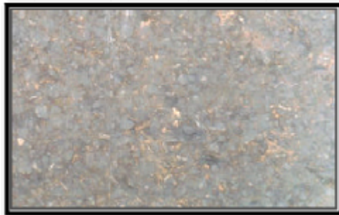
Gambar 2.6 Kerusakan Pelepasan Butir(I Nyoman Jagat Maya, 2011)
