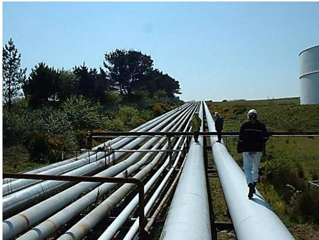
**Gambar 2.1.** Inspeksi visual pada sebuah *pipeline* [10].
