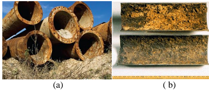
Gambar 1.2. Pipa yang terkorosi (a) external [7] dan (b) internal [8].
