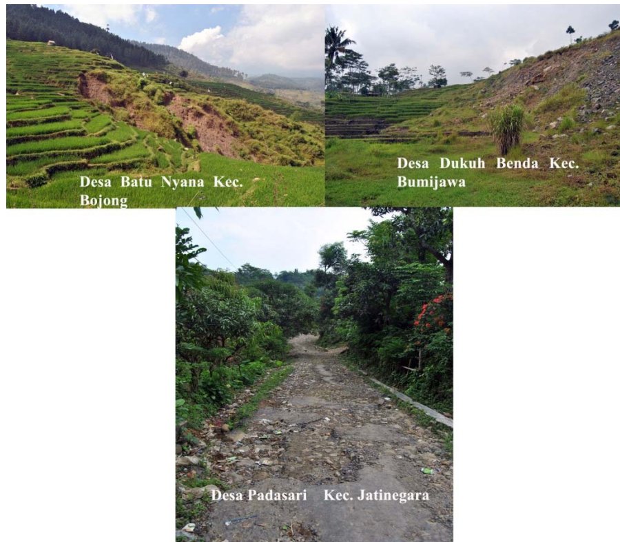
Gambar 2. Kondisi Wilayah Desa Rawan Longsor di Kabupaten Tegal
