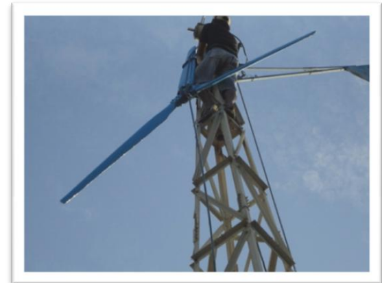
2. Pemasangan sudu di tower
