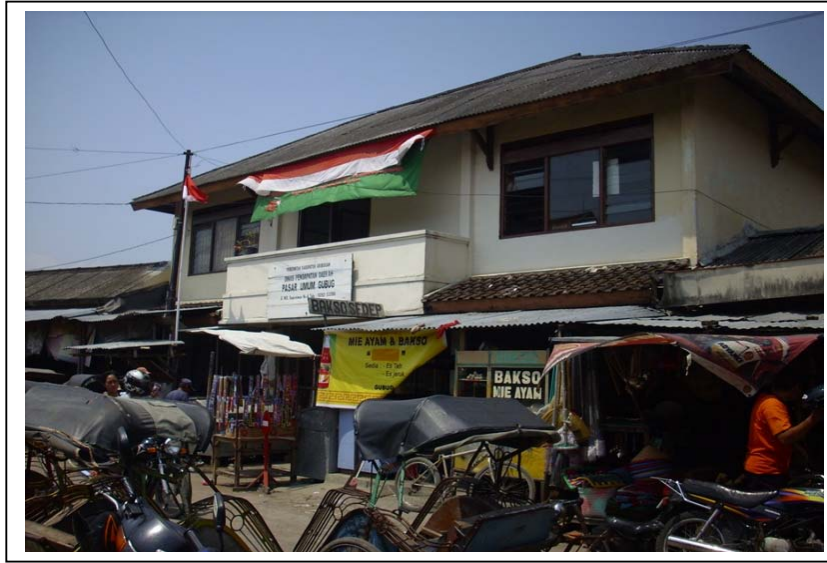
Gambar 4. 2 Tampak Depan Pasar Umum Gubug dengan Atap Berbentuk Pelana dan Bahan Penutup dari Seng (Februari 2009)
