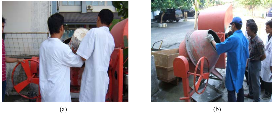
Gambar 3.4. (a) , (b) Pencampuran material beton
