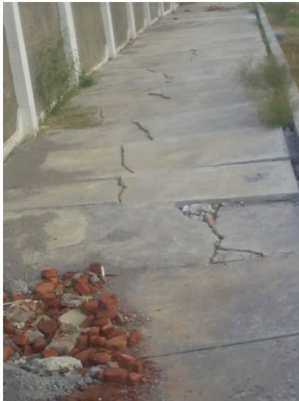
Gambar 1.2. Keretakan pada salah satu lantai tribune timur
