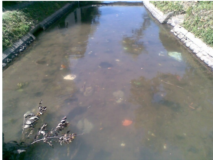
Gambar 1.3. Pengendapan sedimen pada saluran primer
