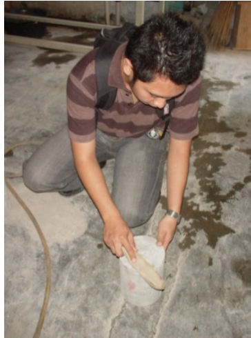
Gambar 3.3. Menyikat permukaan yang diekspos
