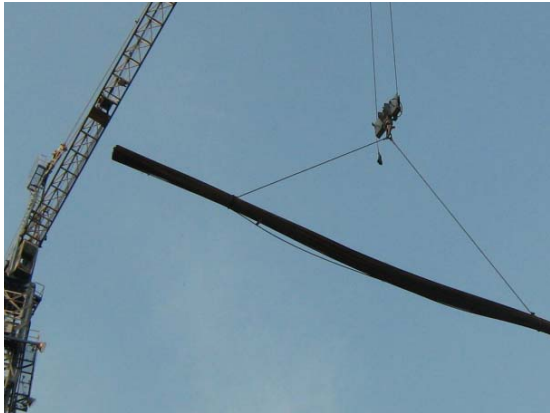
Gambar 3.2 Pekerjaan Pengangkutan Tulangan Balok dan Pelat Lantai
