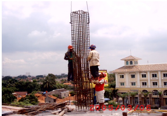
Gambar 3.1 Pekerjaan Pengangkatan Tulangan Kolom
