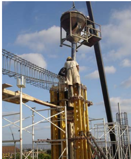
Gambar 3.3 Pekerjaan Pengecoran Tulangan Kolom
