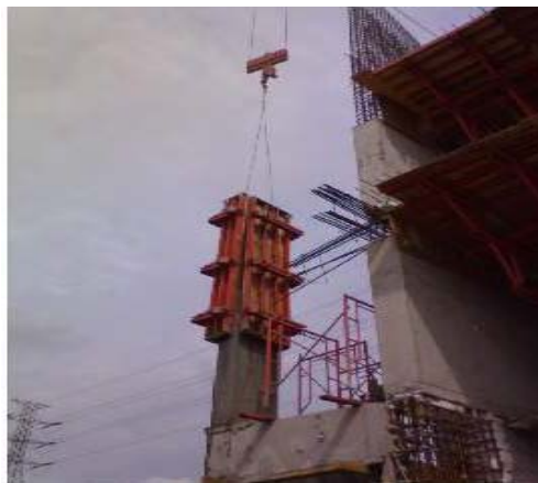
Gambar 3.4 Pekerjaan Pengangkatan Bekisting Kolom
