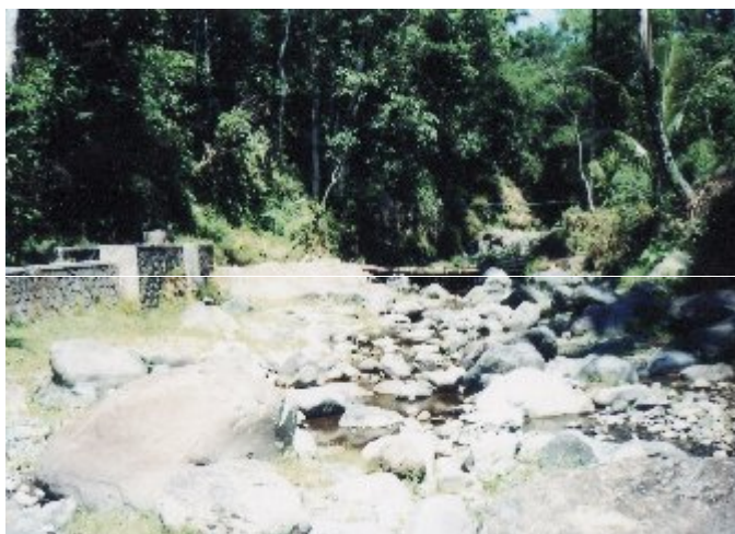
Gambar 2.2 Keadaan Hilir Bendung Susukan Sebelum direhabilitasi
