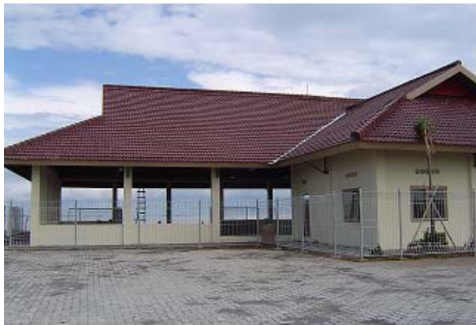
Gambar 1.3 Tampak Samping TPI Yang Baru Dibangun
