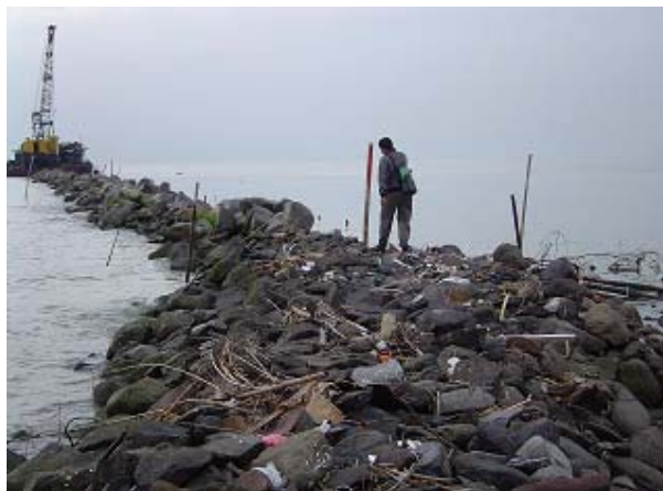
Gambar 1.4 Breakwater Sisi Timur
