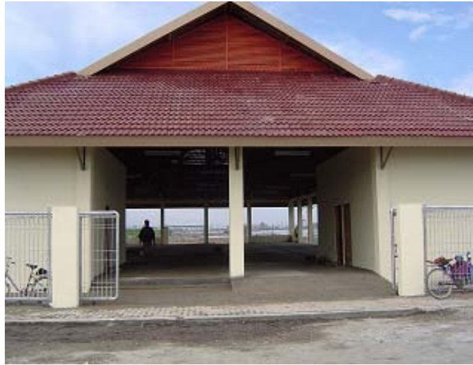
Gambar 1.2 Tampak Depan TPI Yang Baru Dibangun
