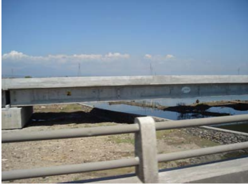
Gambar 1.3 Jembatan Kali Tenggang
