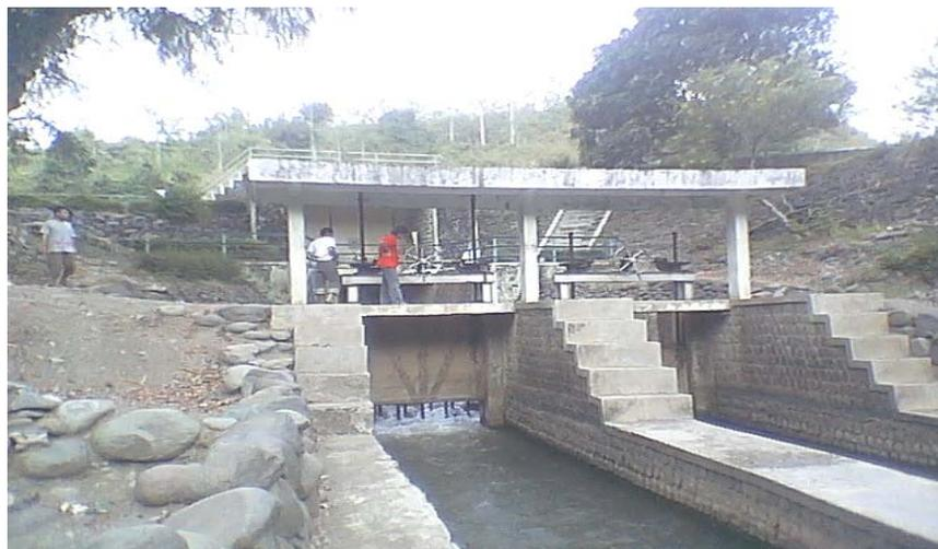
Gambar 2.11 Pintu *Intake* bendung saringan bawah
