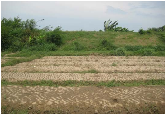
Sumber : Survey Lapangan
