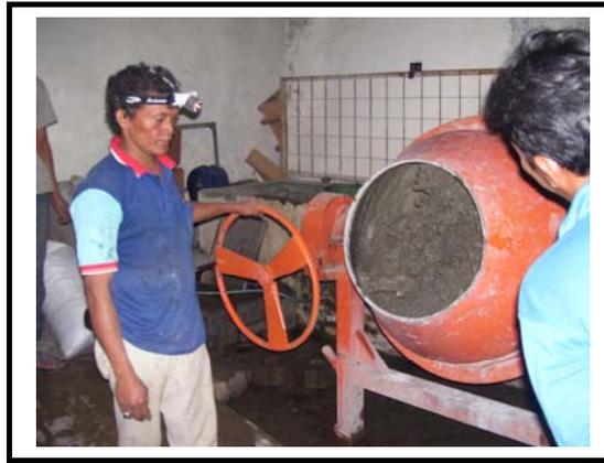
**Gambar. 3.6.** Pembuatan Adukan Beton
