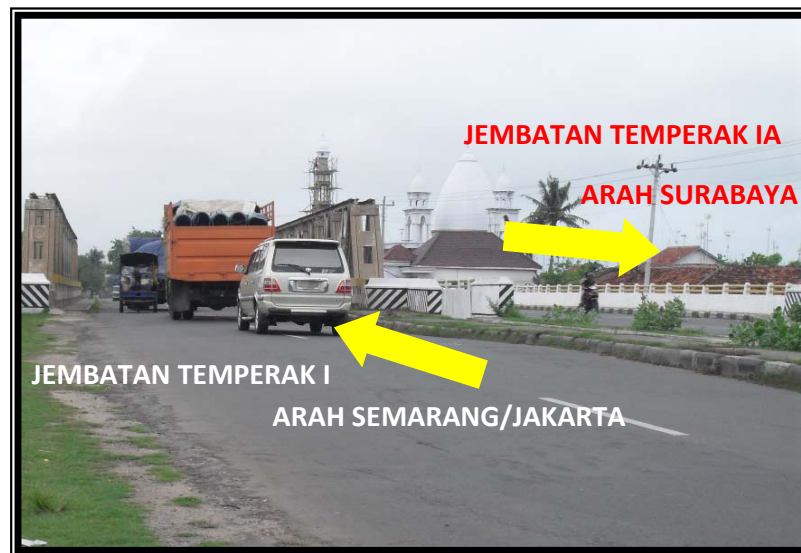
Gambar 1.2 Lokasi Jembatan Temperak I dan Jembatan Temperak IA
