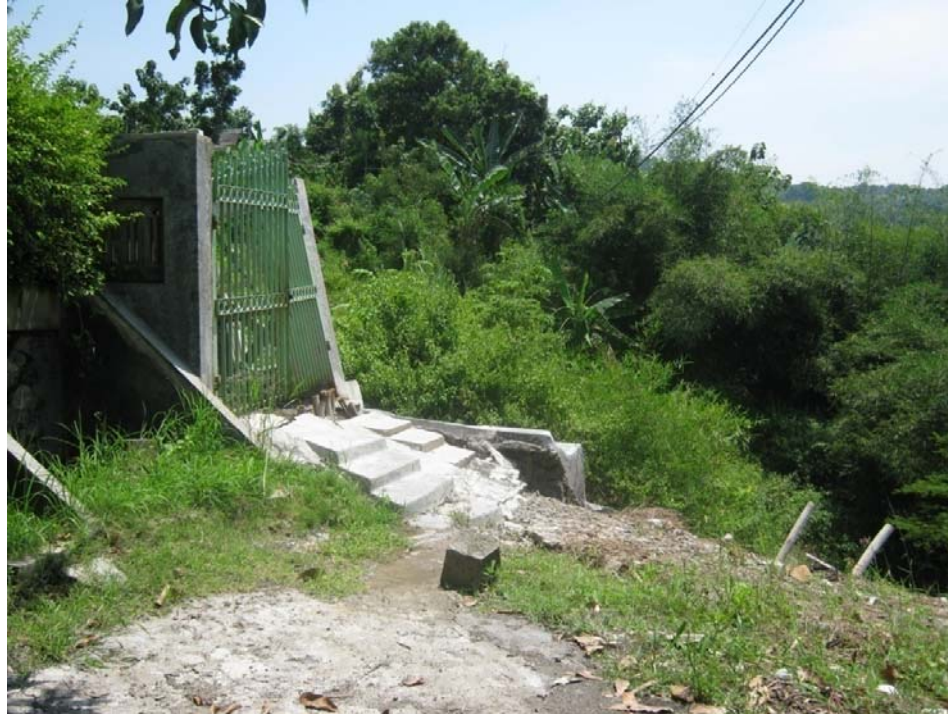
Gambar 1. 4 Ruas Jalan yang terputus akibat ambles
