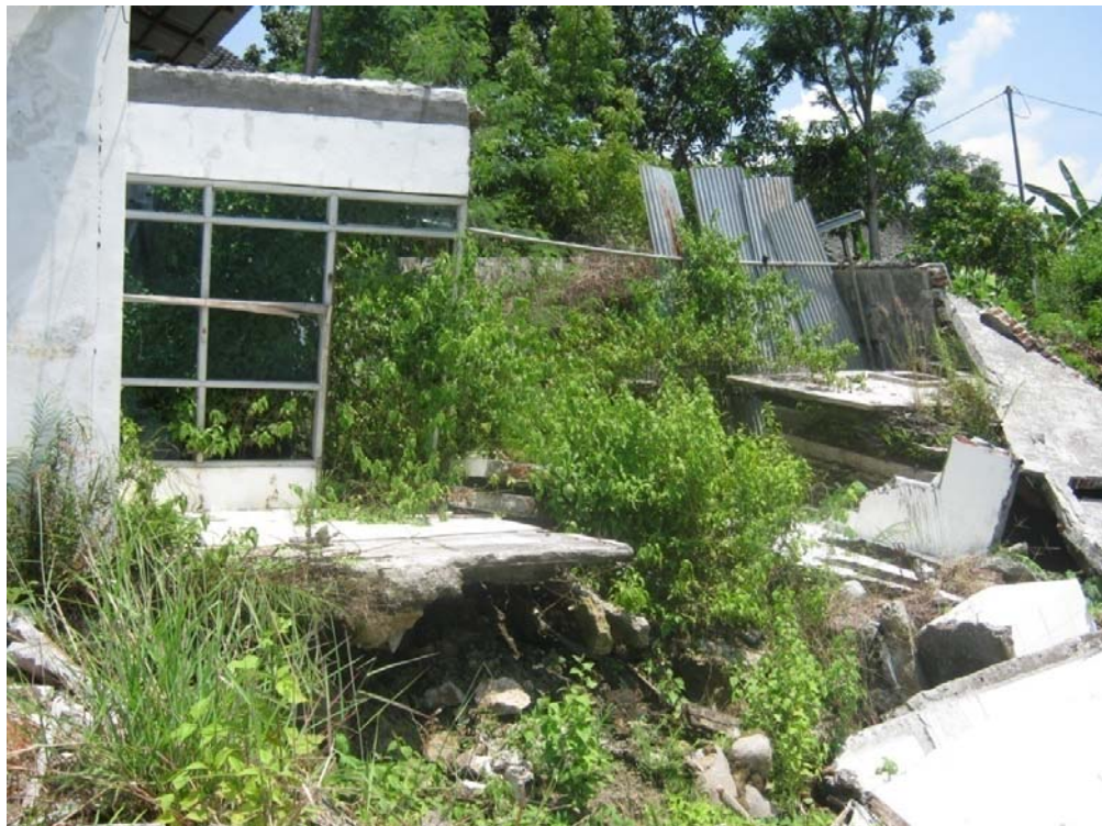
Gambar 1. 3 Rumah yang hancur akibat tanahnya mengalami longsor
