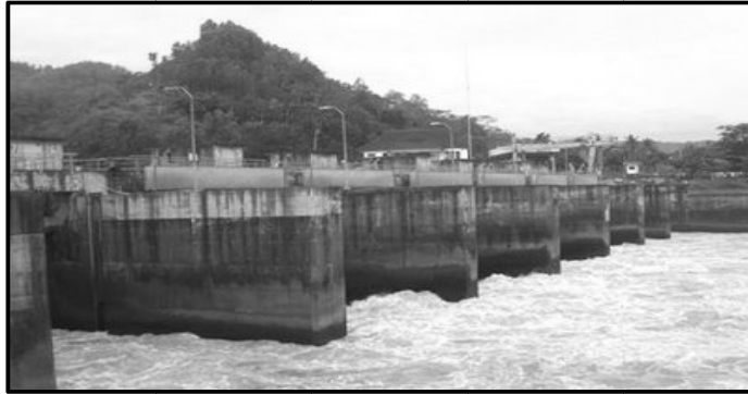
Gambar 1.2 Kondisi Eksisting Bendung Gerak Bengawan Solo
