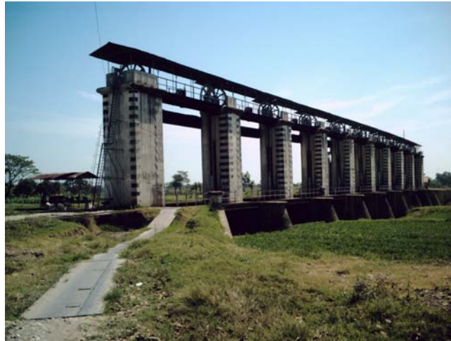
Gambar 1.1 Pintu Banjir Wilalung pada Tahun 2008
