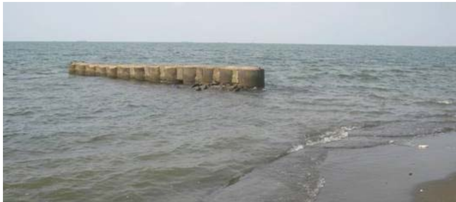
Gambar 1.4 Groin pada Pantai Maron (detail B)
