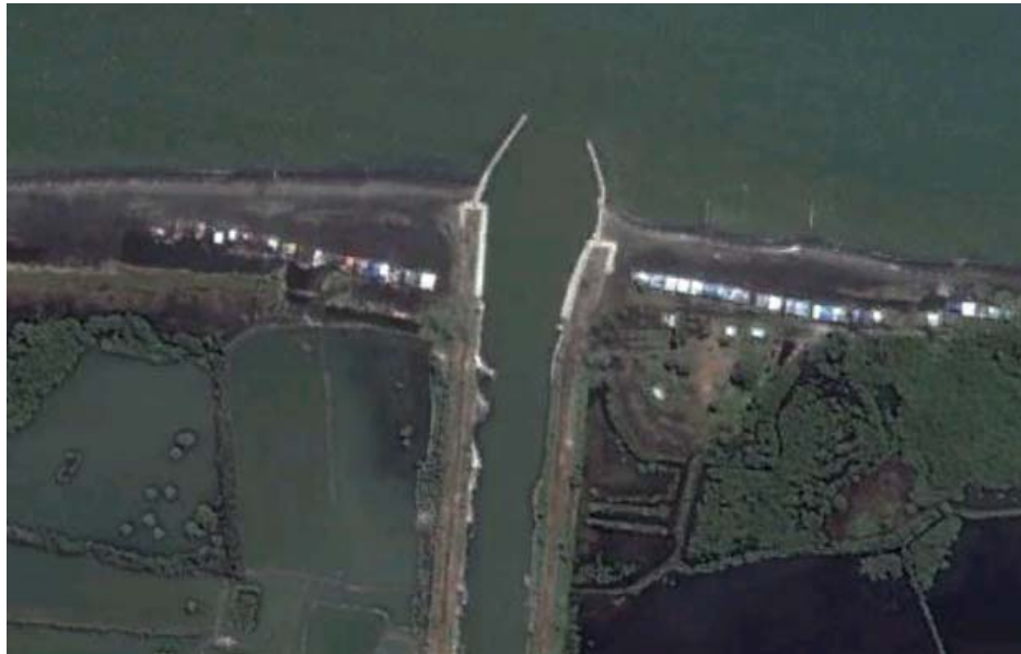
Gambar 1.2 Bangunan pengaman Pantai Maron eksisting
