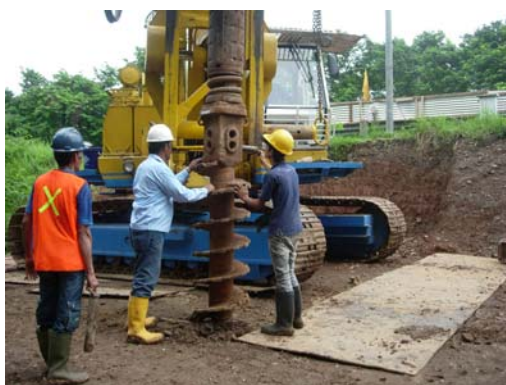
Gambar 1. 4 Pengeboran Tanah
