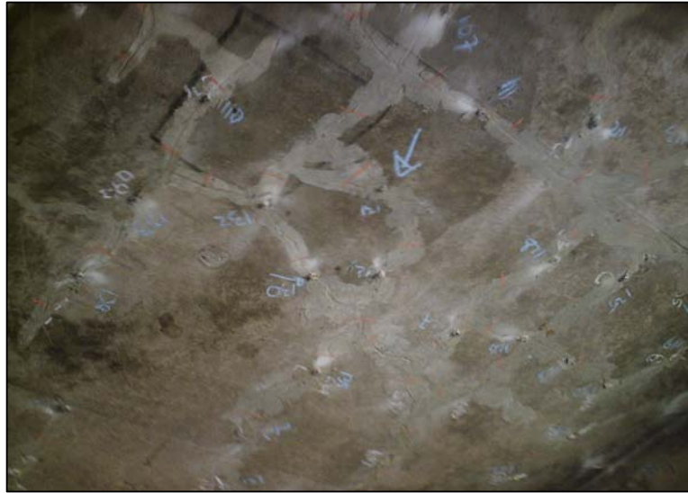
Gambar 1.3. Detail keretakan yang terjadi pada tengah struktur pelat lantai kaki seribu sebelah timur
