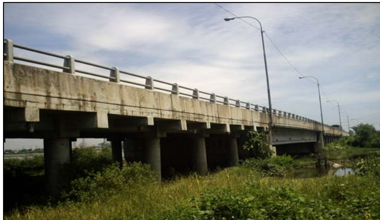
Gambar 1.1. Kondisi pelat lantai kaki seribu jembatan kali Tenggang
