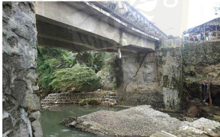
**Gambar I.4 Pilar jembatan yang roboh akibat terjangan banjir**
