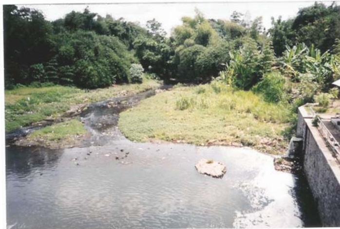
Gambar 2.4 Bagian Hilir Bendung Mrican Existing
