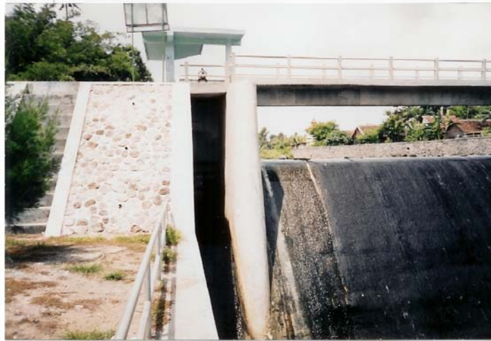
Gambar 2.5 Pintu Pembilas Bendung Mrican Existing
