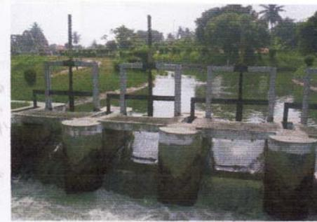
*Talang B.Pkl.1h di saluran induk P. Kletak Bangunan Bagi B. Pkl.1 yang membagi air ke Saluran Induk Rowokembu dan Saluran Sekunder Podo Timur*
