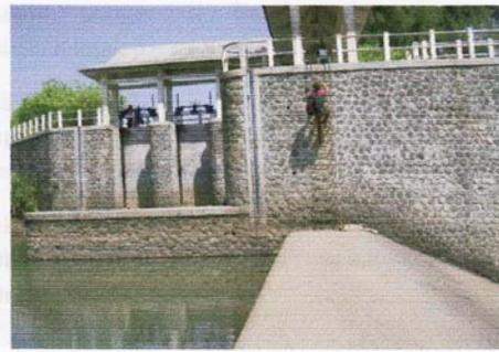
*Bendung Pesantren Kletak dilihat dari bagian hilir Intake Bendung dengan 2 buah pintu. Intake ini ke arah kiri*
