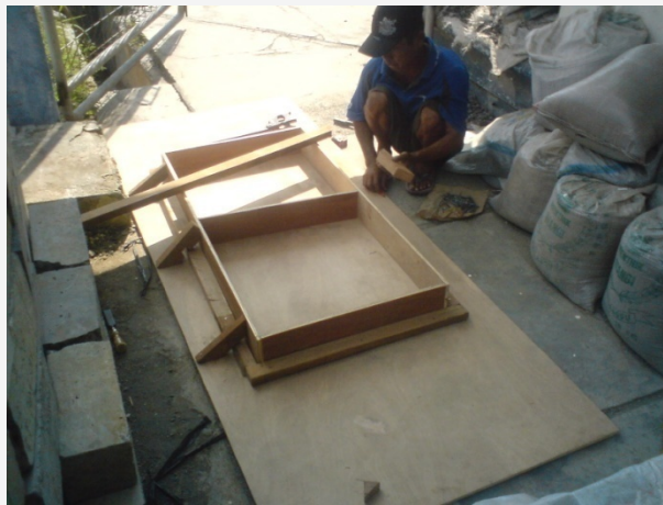
Gambar 3.10. Proses pembuatan Bekisting
