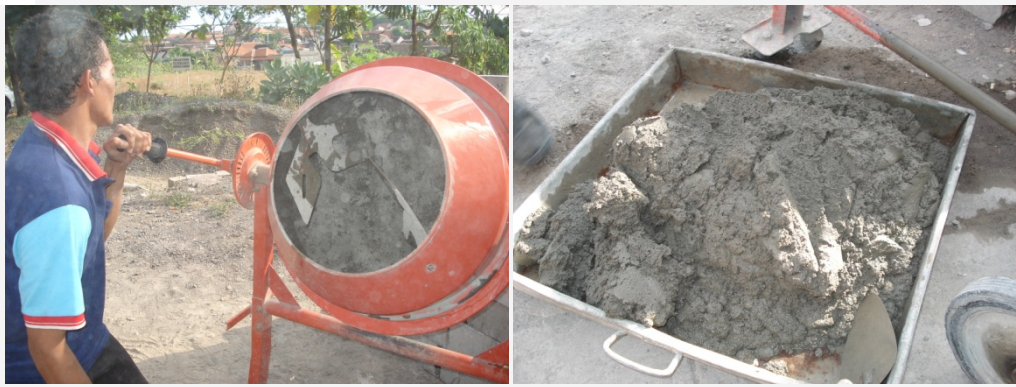
Gambar 3.14. Proses pembuatan adonan mortar
