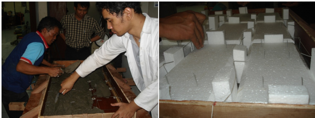
Gambar 3.15. Proses pengecoran layer pertama dan pemasangan Styrofoam
