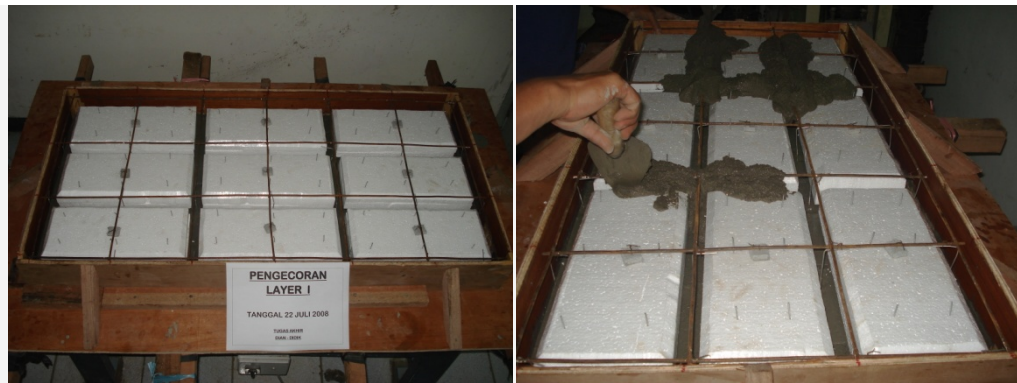
Gambar 3.16. Pemasangan tulangan atas dan proses pengecoran layer kedua
