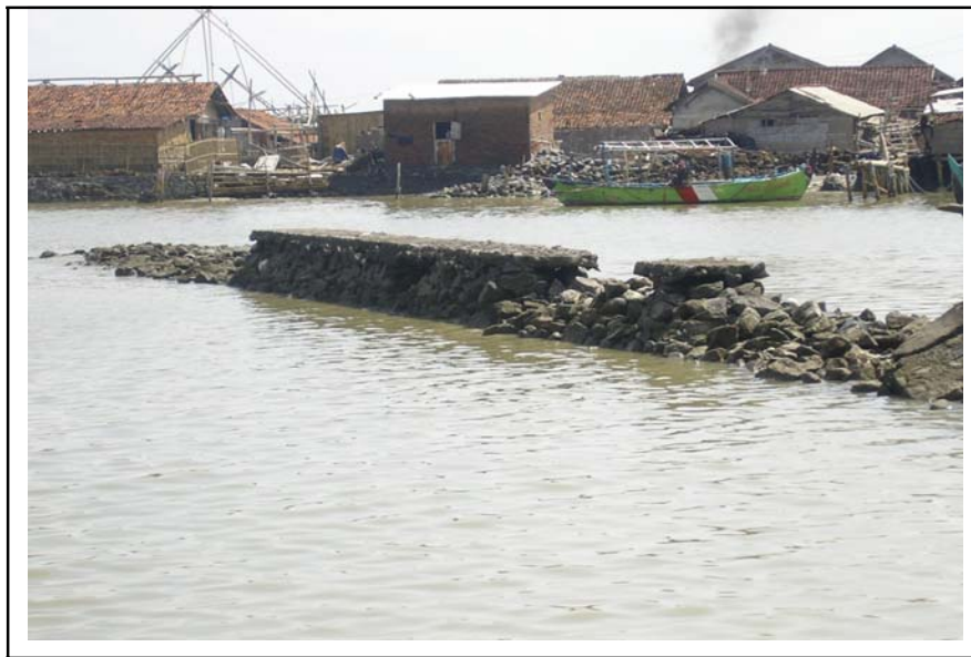
Gambar 4.1. Sea wall rusak akibat abrasi.
