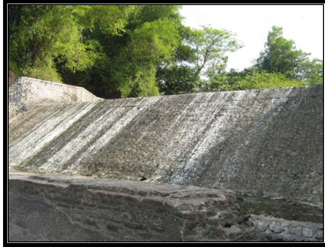
Gambar 2.5 Tampak bagian hilir Bendung Kali Kebo
