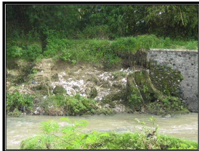
Gambar 2.8 Kerusakan pada talud
