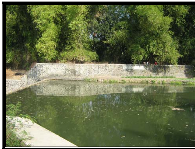
Gambar 2.4 Kondisi Bendung Kali Kebo pada musim kemarau
