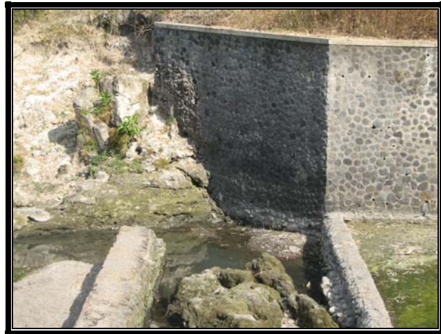
Gambar 2.6 Gerusan / Scouring yang terjadi pada ujung bantalan air
