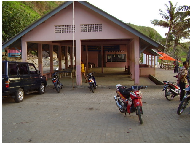
Gambar 4.2. Gedung Tempat Pelelangan Ikan (TPI)
