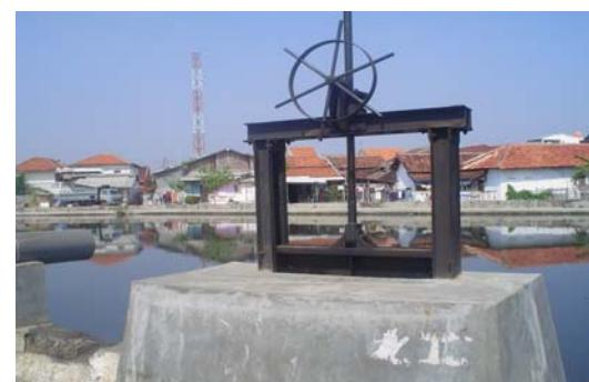
6). Pintu air (outlet) drainase pompa 3 perlu perbaikan karena rembes, air pasang (rob) dari Kali Semarang masuk ke saluran penduduk.
