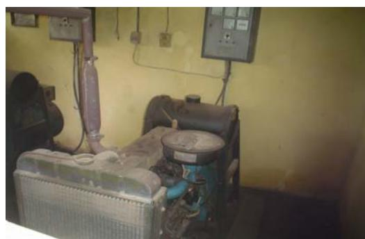
5). Genset pompa 3 kapasitas  $0,12 \text{ m}^3/\text{det}$  jumlah 1 pompa kondisi perlu perbaikan kapasitas sudah tidak optimal.
