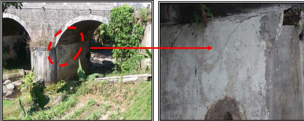
Gambar 4. 6. Keretakan Pada Pilar
