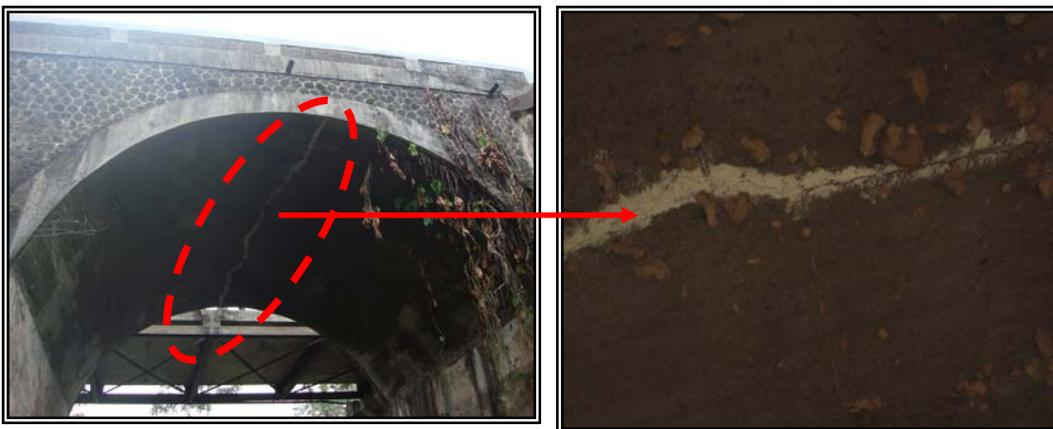
Gambar 4. 7. Keretakan Pada Plat Pelengkung Jembatan
