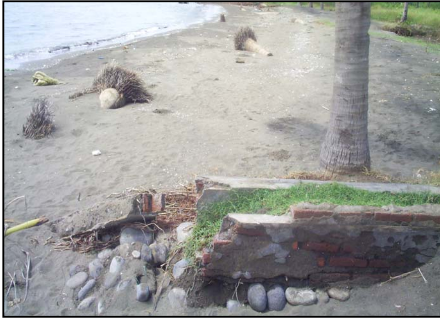
Gambar 4.1. Pondasi rusak akibat abrasi.
