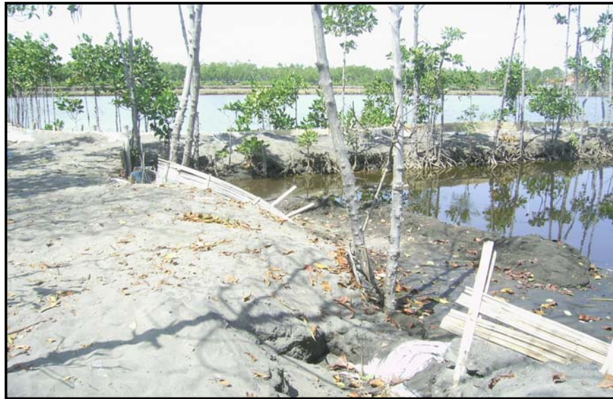
Gambar 4.3. Tambak rusak dan tercemar air laut akibat terjadi abrasi.
