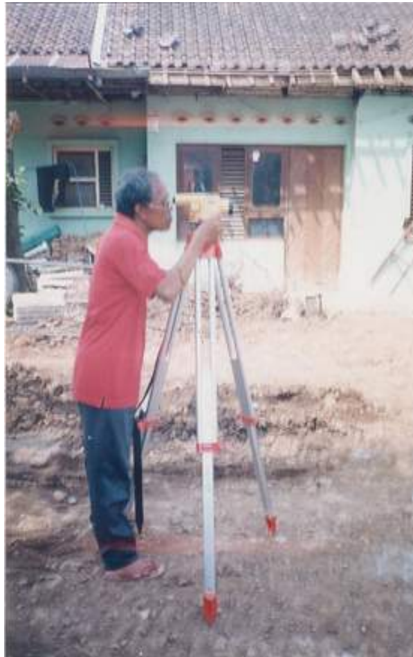
Gambar O. Pekerjaan Pengukuran
