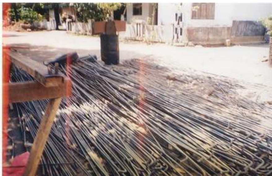
Gambar K. Besi Yang Sudah di Bengkokan
