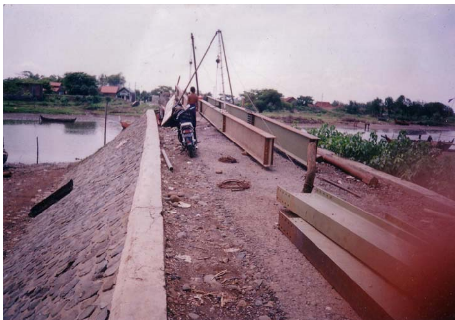
Gambar B. Penempatan Gelagar Jembatan
