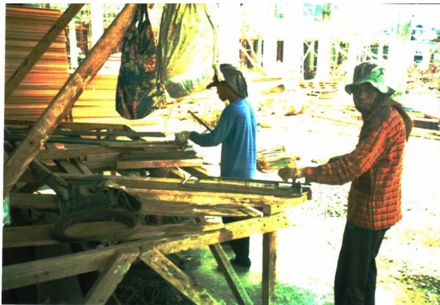
Gambar A. Pekerjaan Pembesian
