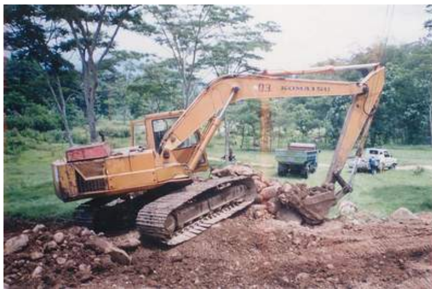
Gambar N. Excavator
