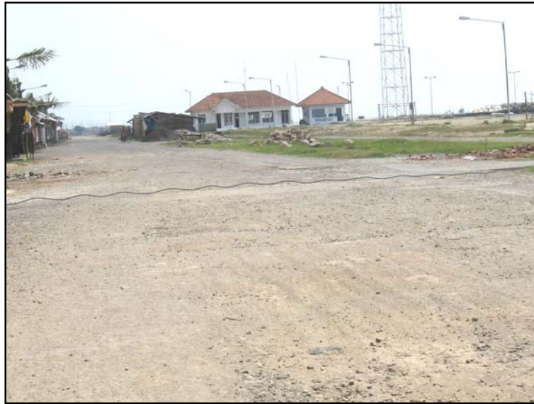
Gambar 3.3. Jalan Komplek TPI Tasik Agung Rembang
