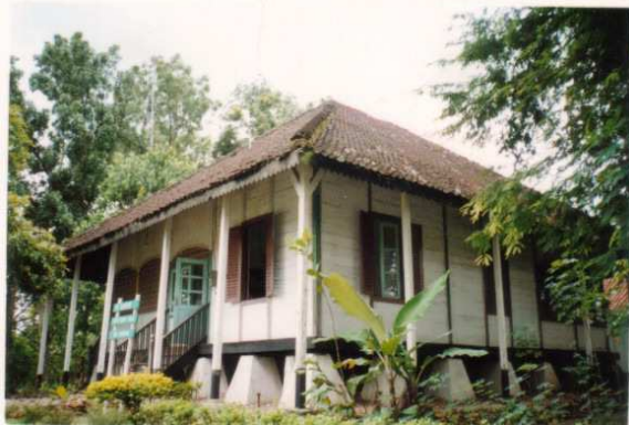
Gambar 2 : Rumah Dinas dengan Pondasi Umpak
