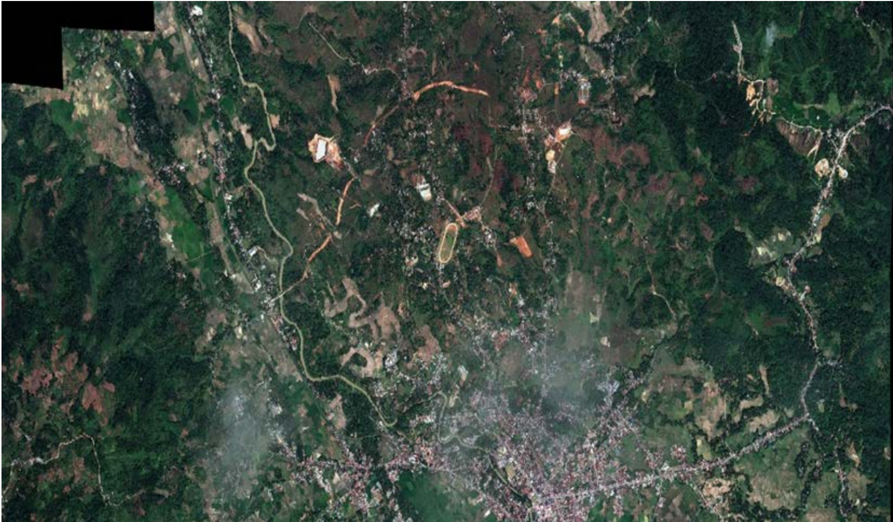
Gambar Tampak Pembangunan Jalan Lingkar Utara Kota Solok dari Foto Udara (Sumber : Bappeda Kota Solok Tahun 2011)
