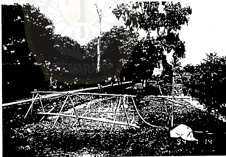
KABEL LINTASAN MELEWATI SUNGAI DIBUATKAN TITIAN, DAN KABEL LINTASAN MELEWATI JALAN RAYA, KABEL DIPASANG DIATAS JALAN DENGAN CARA MELALUI POHON YANG TNGGI
