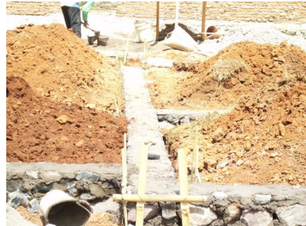
Gambar pemasangan pondasi batu kali
